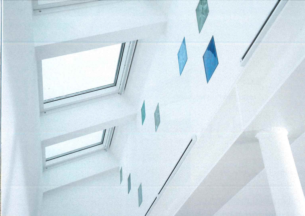
Glasbausteine lenken Tageslicht in das Obergeschoss.
